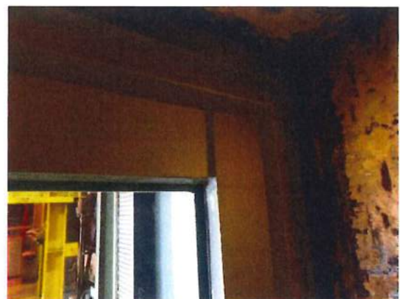
写真6 上部アルミ押し縁（屋外側）
