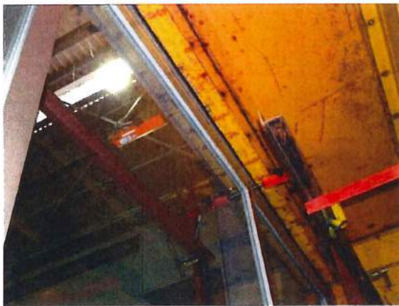
写真 15 変位計設置状況 (試験体上部, 屋外側)
