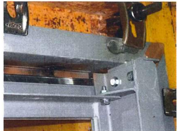
写真4 方立および横材の固定状況（上部）
