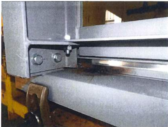
写真3 方立および横材の固定状況（下部）
