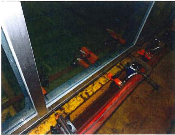
写真 13 変位計設置状況 (試験体下部, 屋外側)
